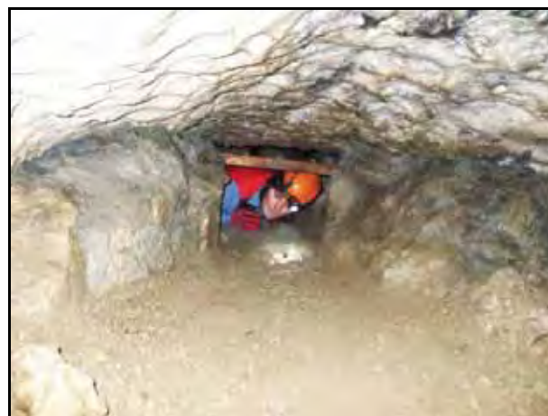
Figure 8. Gate III on Upstream access Gallery. Figura 8. Poarta III pe Galeria de acces amonte.
