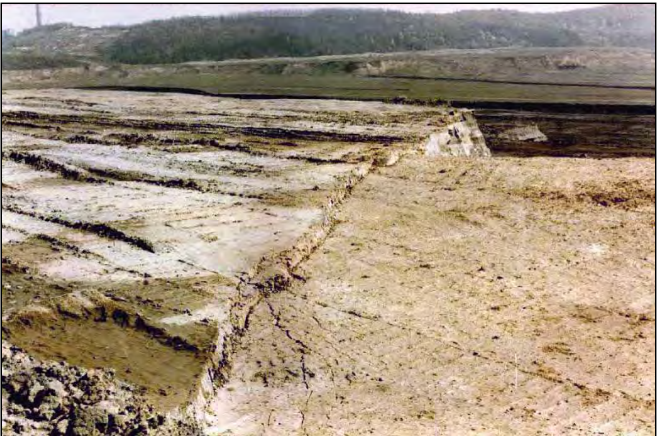
Figure 6. Boncea fault - separation of the excavation block involving X-XI coal beds, Pinoasa area (photo: D. Aninoiu). Figura 6. Falia Boncea cu desprinderea blocului de excavare ce afectează stratele X-XI, perimetrul Pinoasa (foto: D. Aninoiu).
